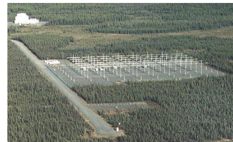
Conjunto de antenas que forma parte de las instalaciones del Proyecto HAARP.
